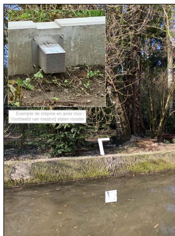
Figure 20 : Exemple de crépine en acier inox
